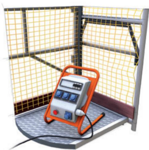
Je branche mes appareils électroportatifs sur un boîtier protégé (30 mA) installé spécialement pour le chantier.
